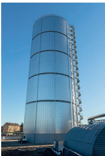
Der Wärmespeicher von N-ERGIE in Nürnberg kann eine Wärmemenge von 1.500 MWh vorhalten.
