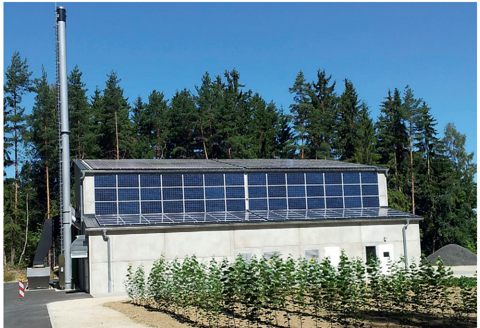
Das Heizkraftwerk von Bad Alexandersbad
