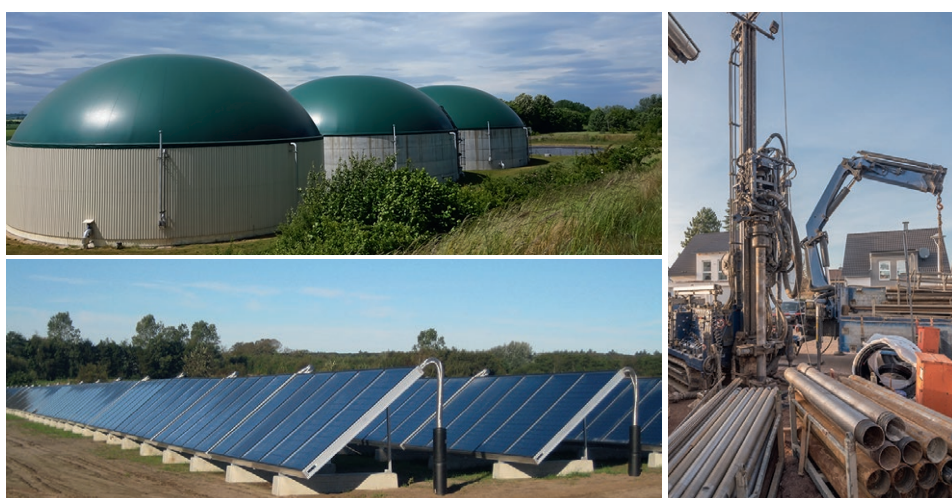
Erneuerbare Energien eignen sich gut zur Wärmeerzeugung: Biogasanlage (links oben), Solarthermie-Anlage (links unten), Geothermie-Anlage (rechts).
