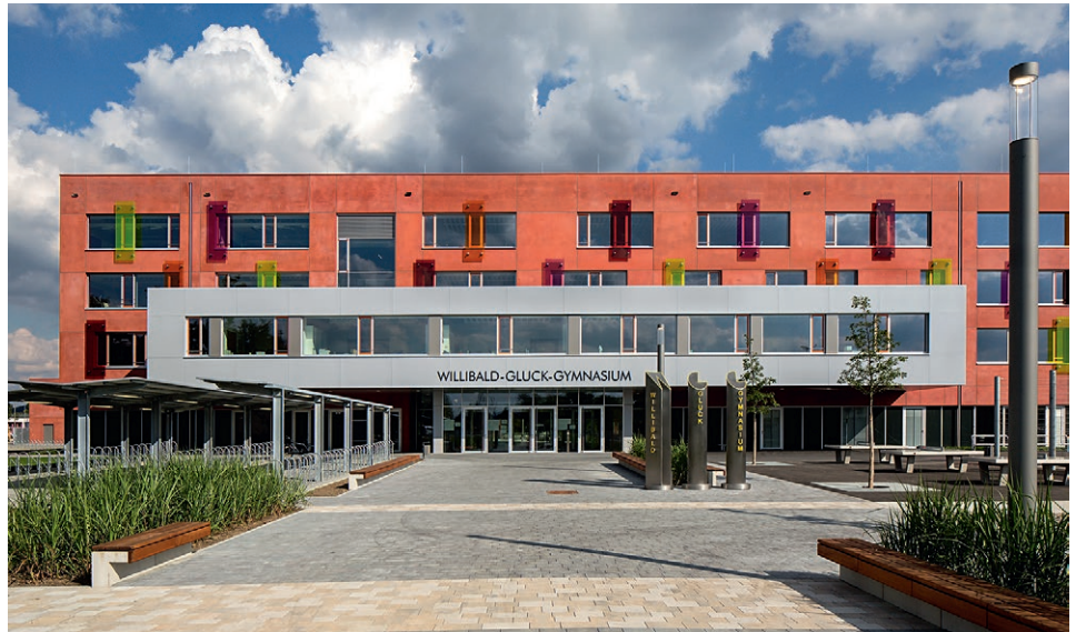
Willibald-Gluck-Gymnasium – Neubau des Schulgebäudes und der Sporthalle
