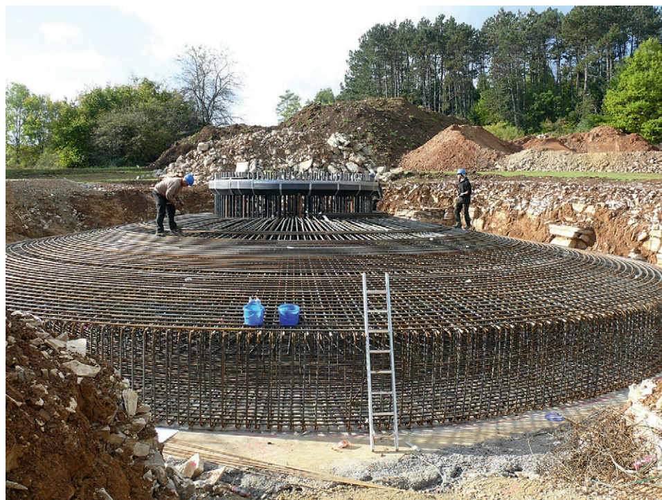
Errichtung des Fundaments
